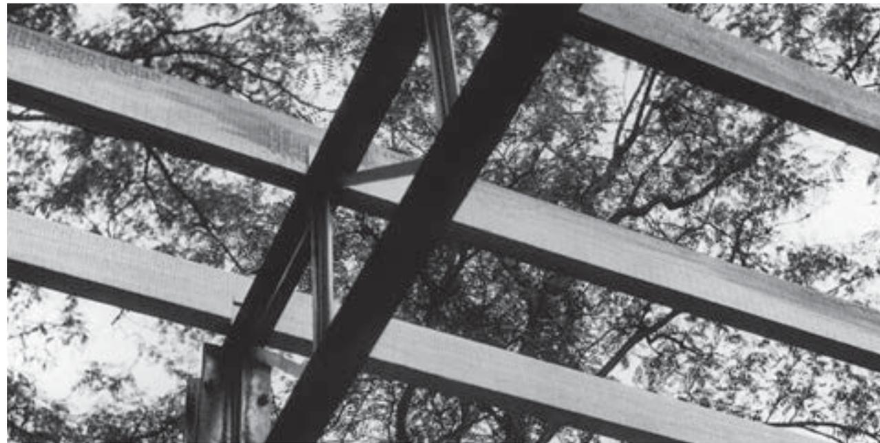
*Detalle del techo. Vigas de estructura metálica y tirantes de madera.*
