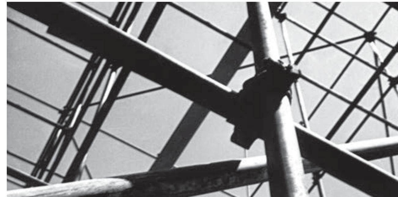
*La gran estructura central cumplió la doble función de sostener, en su exterior, la rampa que llevaba a la planta alta del paseo, y en el interior, el símbolo del Pabellón, de tela tensada roja y blanca.*
