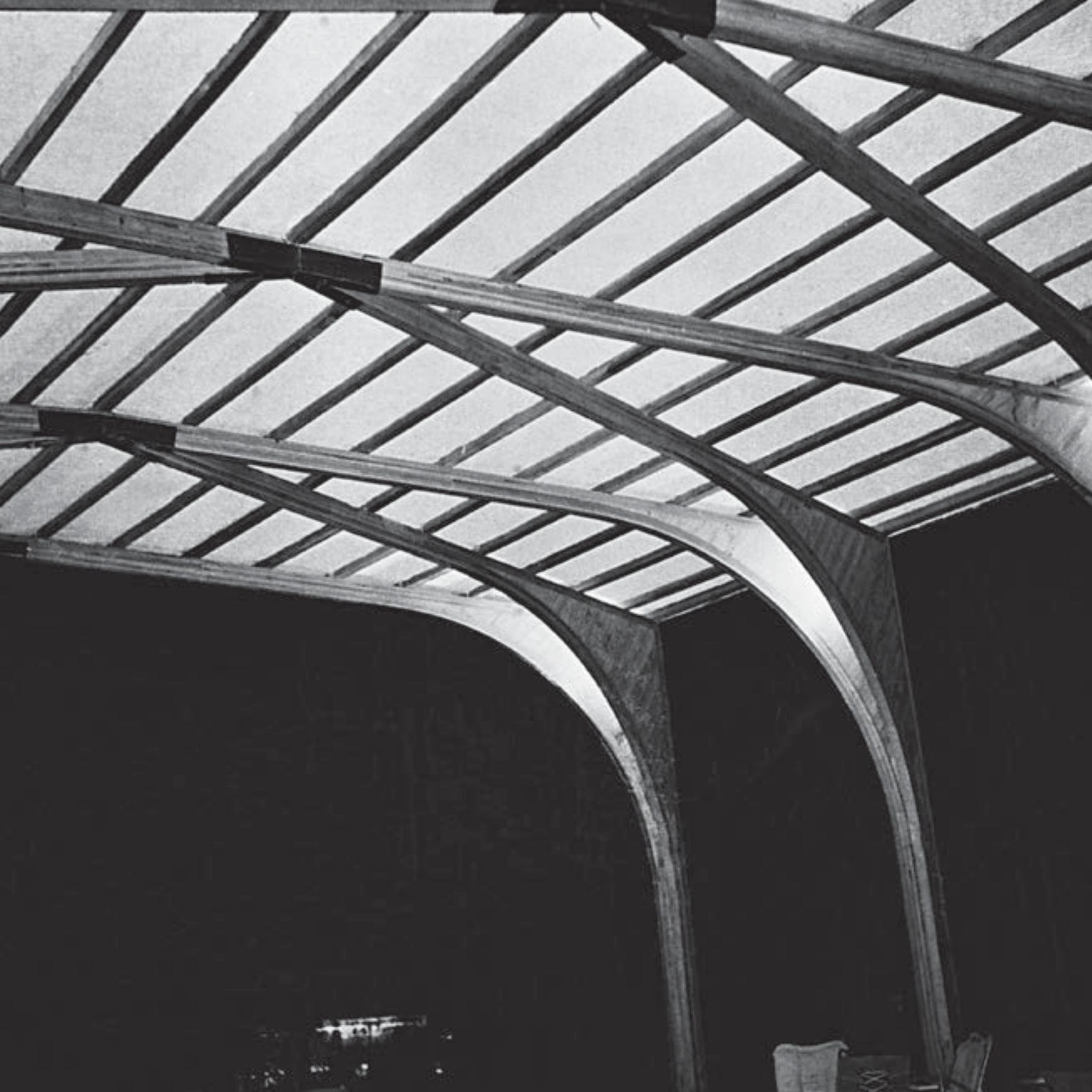
*Detalle de la estructura, planteada a partir de pórticos realizados en madera laminada. La iluminación fue colocada entre las columnas, en dirección al techo.*
