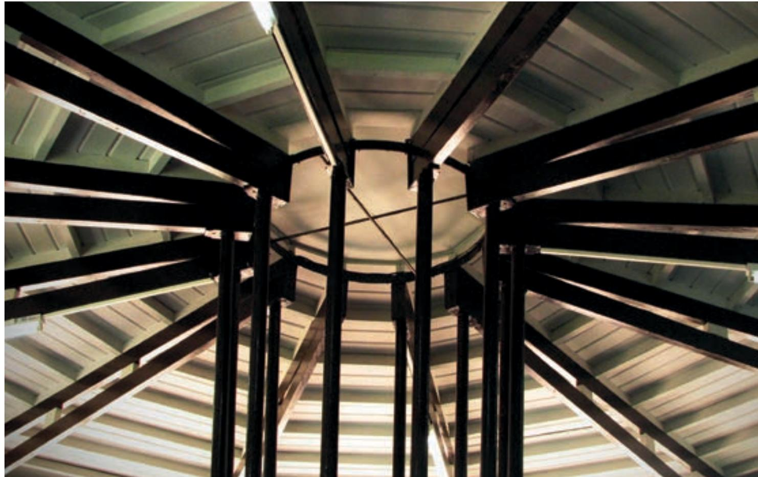
Detalle estructural. Convergencia de vigas radiales hacia el centro del espacio circular.
