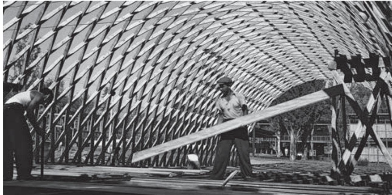
*El Pabellón parabólico se destacó por su original estructura reticular. Se completó con un techo suspendido en su interior y una plataforma que elevaba la cota del suelo. En el cuerpo central, se exhibieron las industrias más*
