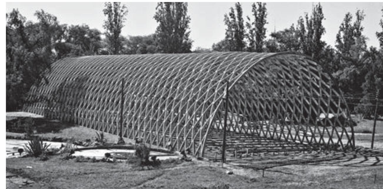
*Detalle de la estructura lamelar.
