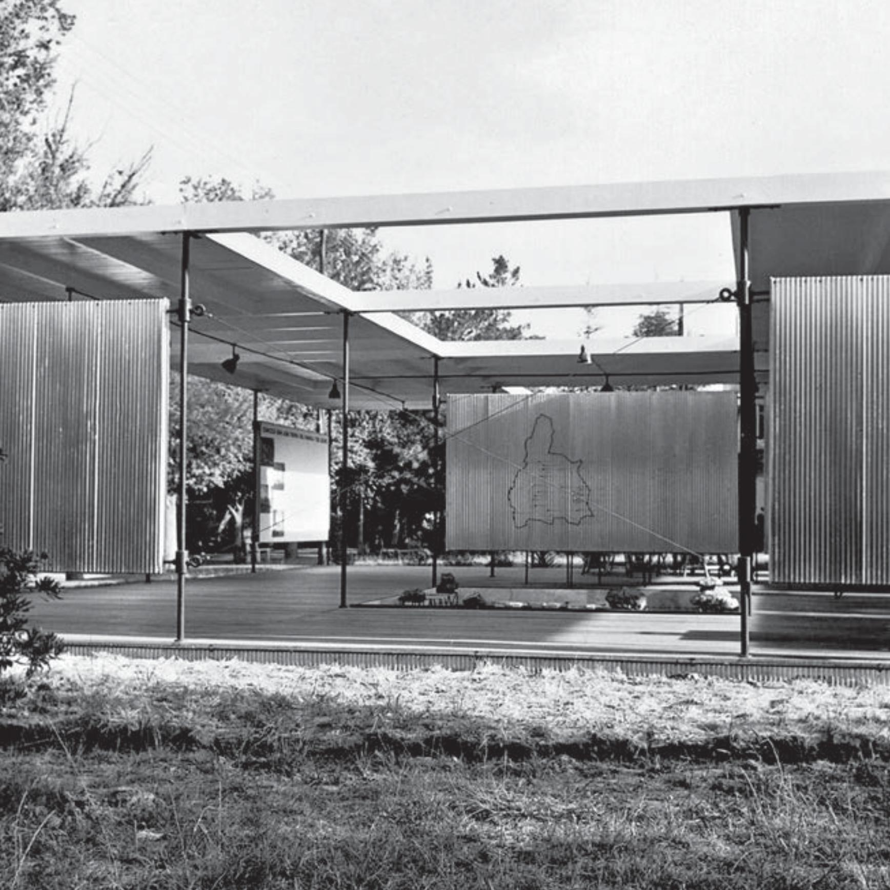
*Interior del Pabellón con disposición de paneles expositivos. Se destaca el uso de chapa acanalada con elementos gráficos corpóreos.*
