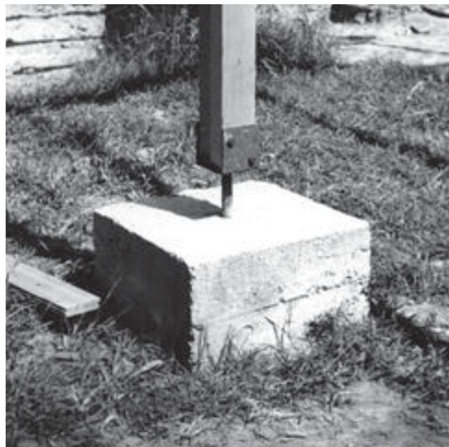
*Detalle de columna en hormigón, hierro y madera. Diseño: Arq. Félix Pineda.*
